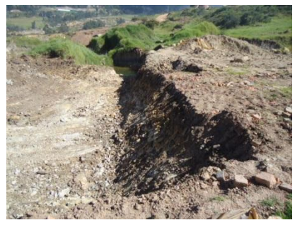
Figura No 2: Frente Excavación perfilados
