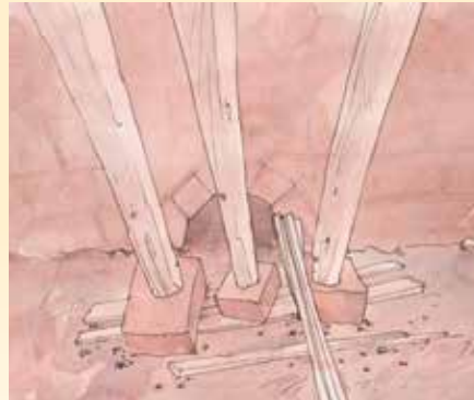
Detalle interior soporte de cercha
