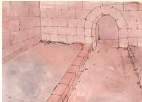
Ductos de chimenea
